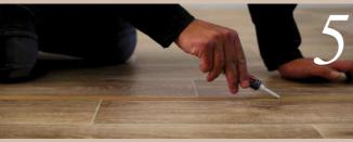
Introduzir a extremidade do bocal na junta e trabalhar para trás, injectando lentamente o fluido até que este transborde para a superfície da fita adesiva de papel. Deixar o fluido de soldadura atuar durante mais de 1
